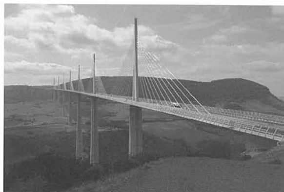
写真-1 ミヨー高架橋
