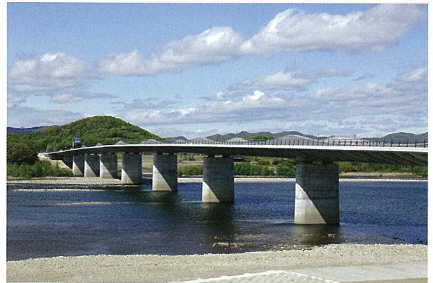
写真-1 堤防から全景を望む各務原大橋
