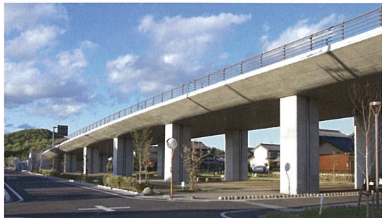
写真-7 アプローチ高架道路の様子
