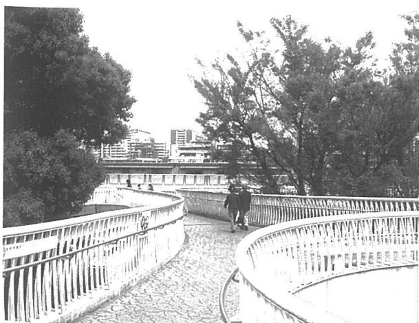
写真-2 橋面の様子
