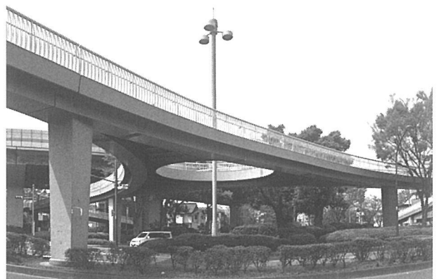
写真-1 下からの見上げ
