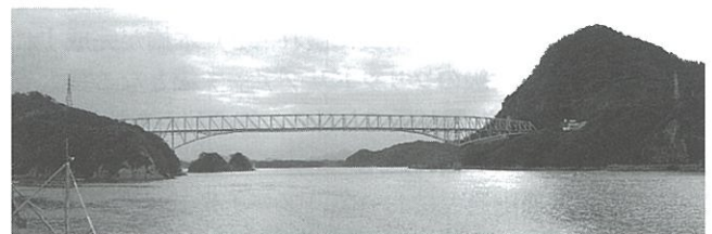
写真-1 現況(中央が天門橋)
