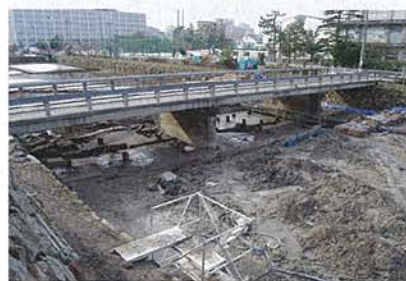
写真4 ■ 発掘調査ではコンクリート橋(1963年建造)の下の地盤から、69本の木製の橋脚遺構が出土した
