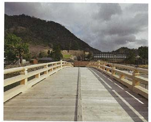
橋の幅員は約6m、全長は約37m。床材と橋脚は、出土した遺構に基づいてクリ材とした。高欄と桁はヒノキ材
