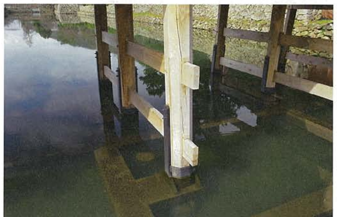
写真6 ■ 明治元年の橋脚遺構は、張り出した水中梁の下(復元橋の橋脚の真下)に位置する。水中梁の横に見える円形状の物体は、別時代の遺構
