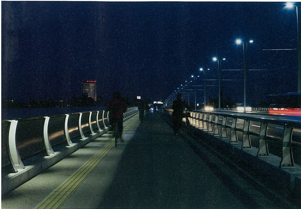
夜景。歩道に必要な平均照度5ルクスは、車道にある照明で確保している。このほか、橋の演出照明として、高欄の手すりにLED照明を組み込んだ
