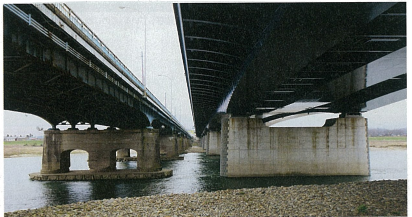
右岸の河川敷から新しい富山大橋(右)と旧橋を見上げる。新しい富山大橋では、三つの箱桁のうち両側の二つを支承で支えることで、橋脚の中央天端部分で視線が抜けるようにした
