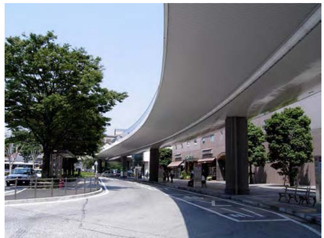
写真-4 桁下空間
