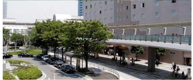
写真-1 現地状況（上/施工前、下/施工直後）
