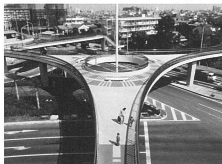
⑲ 1977 蓮根歩道橋 (東京都・板橋)
