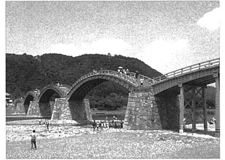
③ 1630 錦帯橋 (岩国市)
