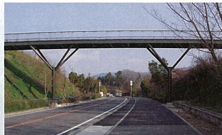
香川県の国営讃岐まんのう公園の「希望の橋」。自然の樹木を連続させる立体Y字橋脚鋼ラーメン桁橋
