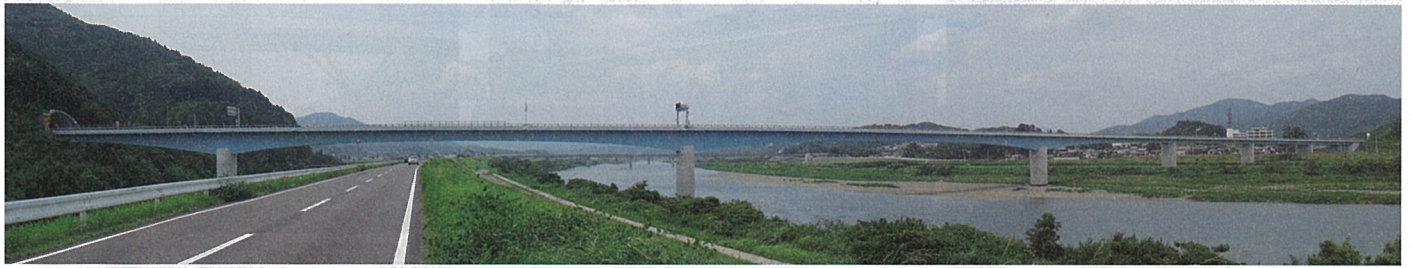
新四万十川橋の全景。橋の上は国道56号。写真左側の背割堤の上には国道321号が通る。桁の色は日本の伝統色「瓶覗き(かめのぞき)」を採用(写真:26ページまで特記以外は大日本コンサルタント)
