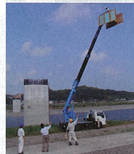
桁の色は、クレーン車で架橋位置に大きな色見本を掲げて確認した
