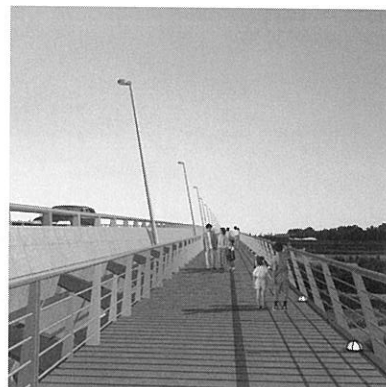
図-3 リサイクル集成木材を使用した歩道デッキ
