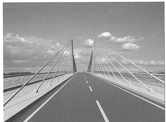
主塔は「各務原リンケージブリッジ」の最も重要なデザイン要素であり、高さを低く抑え、上部に向かって広がりを持たせることにより、爽快な走行イメージを演出します。
