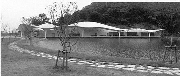
写真-2 コンサートも開かれる美しい建築の市営斎場(設計:伊藤豊雄)
