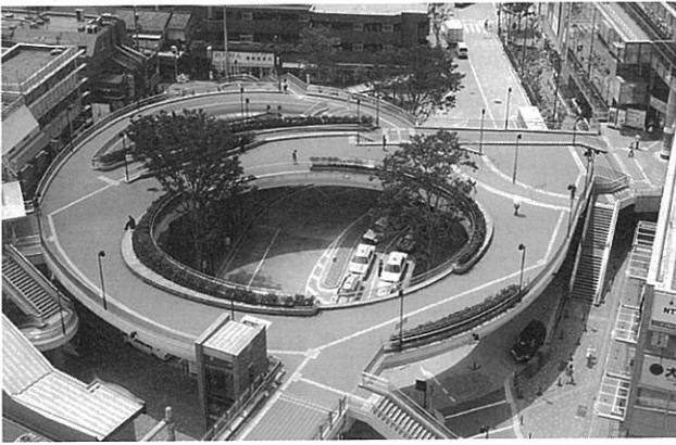
写真-5 大泉学園駅前デッキ（円形階段は右上に見える）
