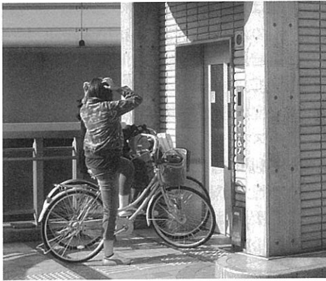
写真-6 大小路歩道橋（足スイッチのあるエレベーター）
