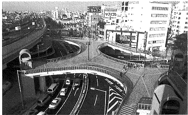
写真-8 大小路歩道橋
