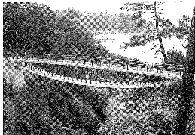
写真-14 巖門園路橋（PCトラス橋）
