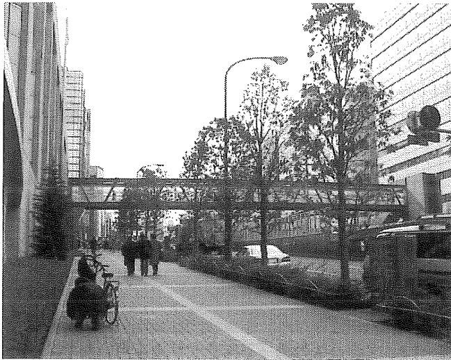
写真-16 透明感のある渋谷歩道橋の全景
