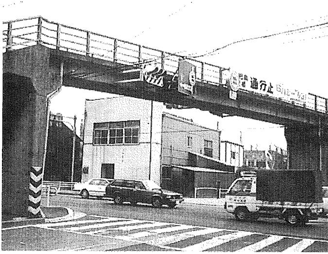
写真―1 我が国最初の歩道橋／西枇杷島歩道橋（これからの歩道橋／技報道出版、p15より）
