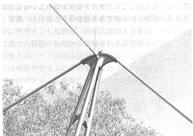
写真-5 ケーブルサドルのディテール／シュライヒ設計の歩道橋（ドイツ／シュツットガルト）
