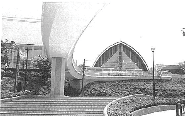
写真-7 桁形状を延長した橋台/白根公園歩道橋 (横浜市)
