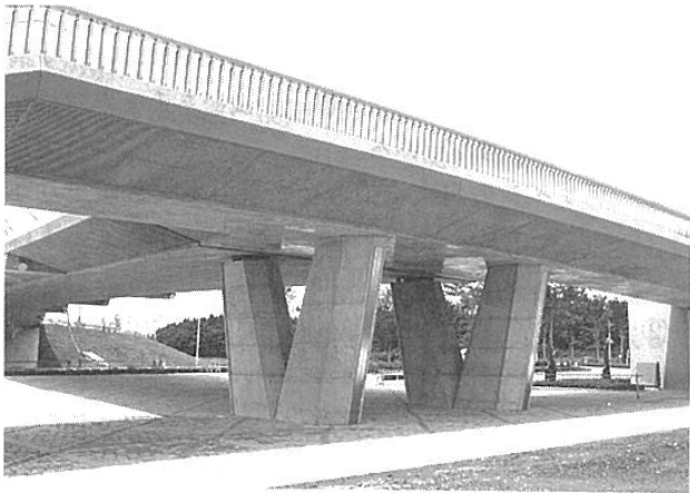
写真-11 V形橋脚／ふれあい橋
