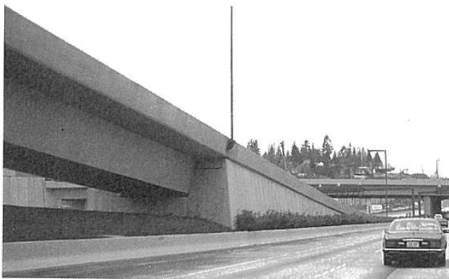
写真-6 橋台部の納め方 (アメリカ/シアトル)
