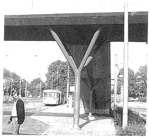
写真-8 橋脚下端部の納め方/シュライヒ設計の歩道橋 (ドイツ/シュツットガルト)
