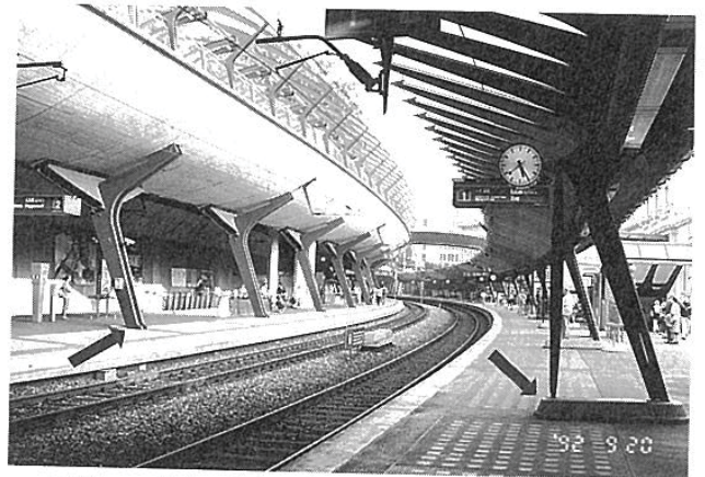
写真-9 橋脚下端部の納め方/カラトラバ設計の駅舎 (スイス/チューリッヒ)
