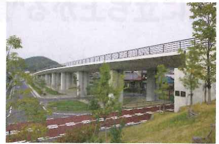
各務原大橋に続くアプローチ橋の桁下空間に、住民と協議しながら広場を整備。写真は右岸側
