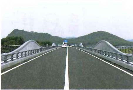
車道から北側を見る。主桁から立ち上がる構造壁は、ドライバーの圧迫感を軽減する狙いもあり、歩道側に傾斜
