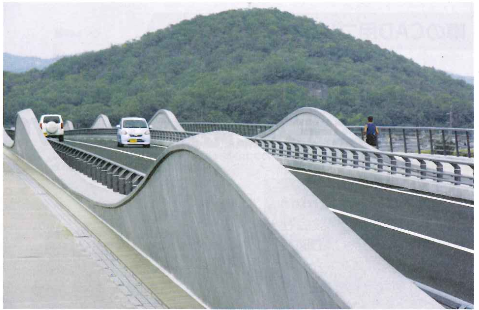
下流側歩道から北東を見る。構造壁の高さは、橋脚の上で2mと最も高く、徐々に高さ50cmに下がっていく。支間長の60mごとに高くなる壁のうねりが、山の稜線と呼応するように続く。構造壁の内側のPC鋼材を保護するため、車道と壁との間に防護柵を設けた
