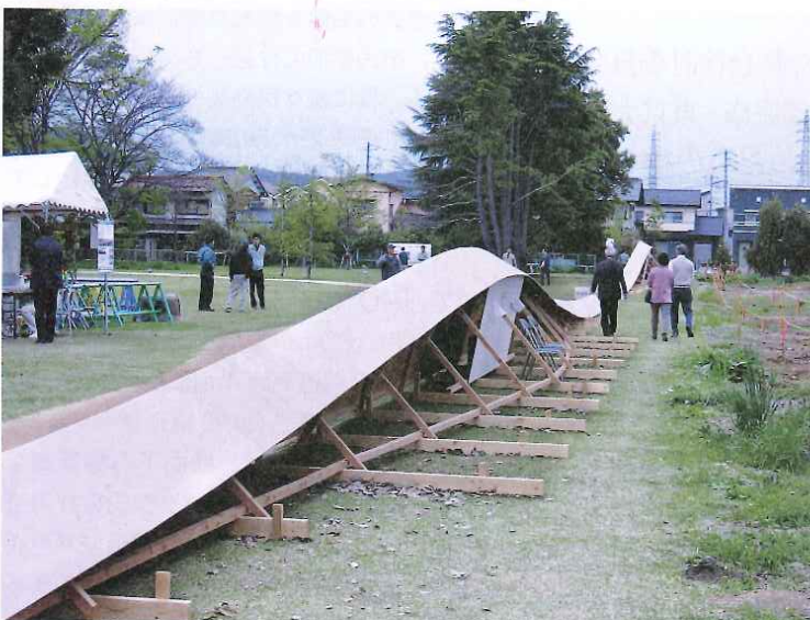
延長120m、高さ2mと1.5mの構造壁の実物大模型を2006年4月に公園に展示。200人の市民アンケートで、回答者の3分の2が2m案を支持した(写真:大日本コンサルタント)
