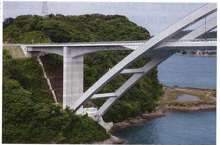
写真4 ■ 側径間をPCのT形ラーメンにして、曲げ剛性によってタイ部材を代替した
