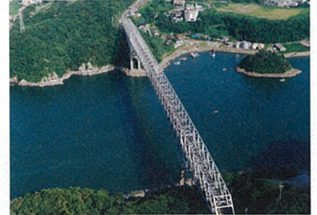
写真3 ■ 着工前。トラス構造の天門橋の写真左側に天城橋を架橋した(写真:熊本県)
