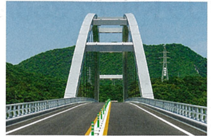
天城橋は自動車専用道路。車両防護柵の高さは1mとした(写真:熊本県)
