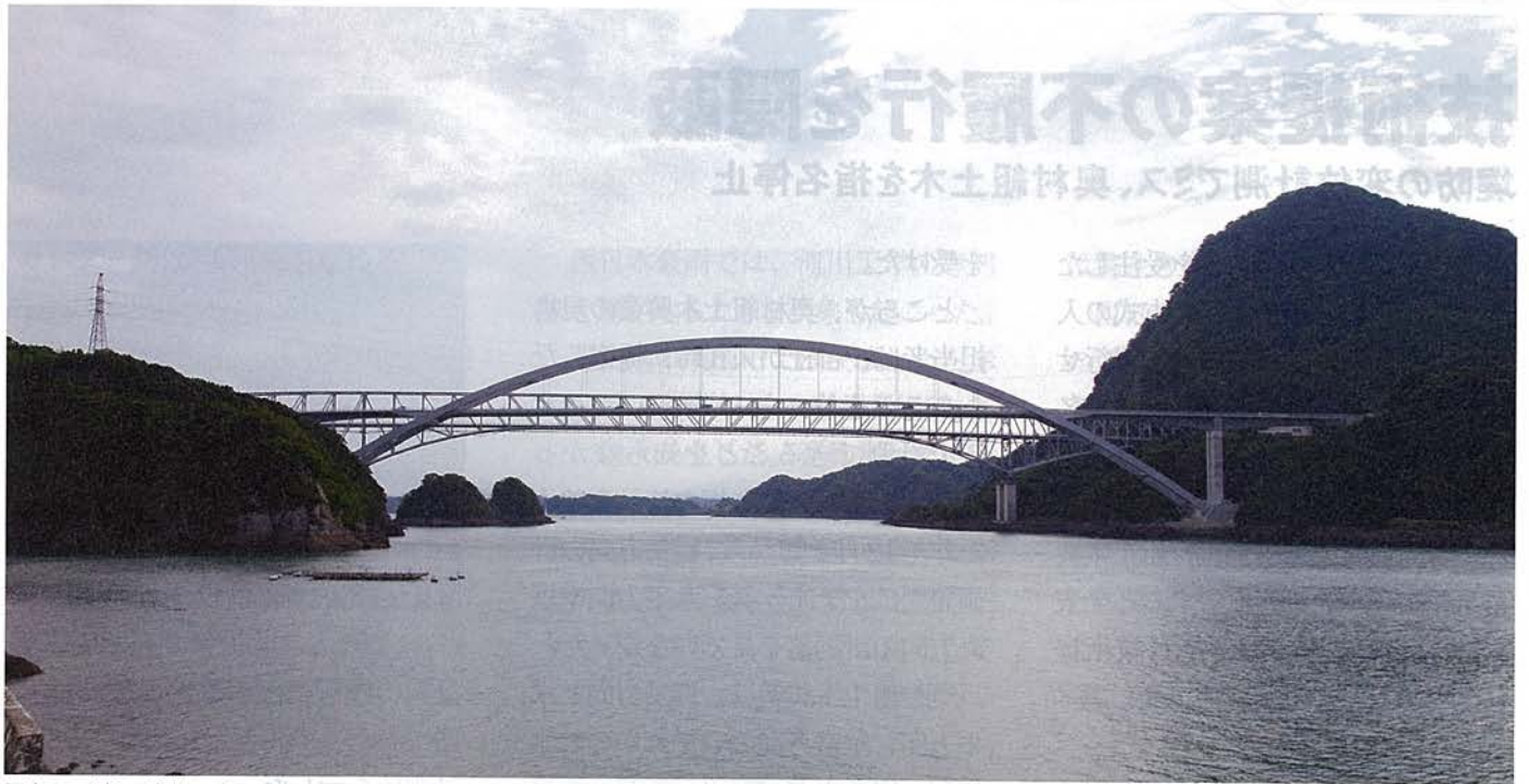
写真5 ■ 北側の護岸から約1km離れた天城橋を見る。奥の天門橋と重なり、「1つの橋のようだ」と好感を持って話す観光客が多かった
