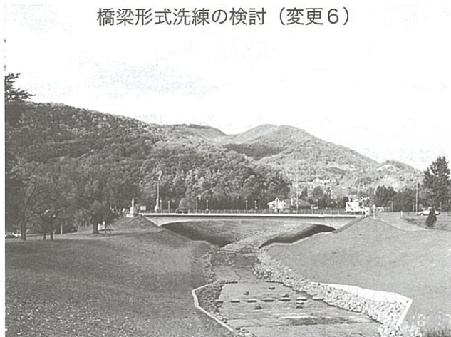
図30 橋梁形式の洗練(2)
