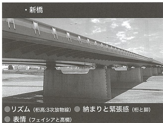
図 37 新富山大橋の側面景
