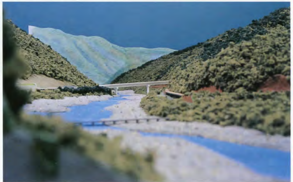
【図5】 橋梁形式の検討事例。橋梁部分を差し替え、周辺景観との調和が検討された
