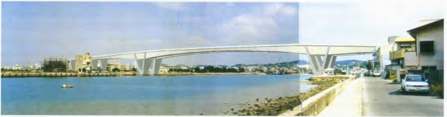
【図9】簡単なCGフォトモンタージュの例。現況に対する橋梁構造物のスケール感の把握に利用
