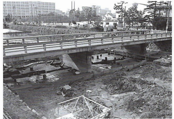
写真-1 既設橋と遺構調査の様子（鳥取市提供）
