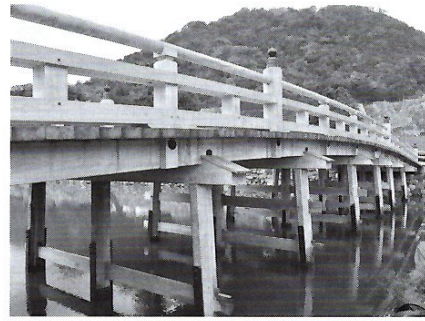
写真-2 完成した擬宝珠橋（水中梁は水面下にあり目立たない）
