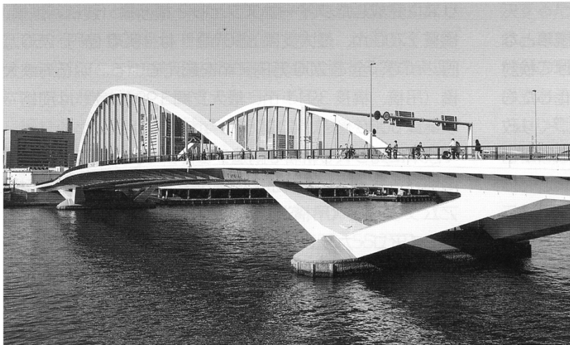
写真2 築地大橋(アーチ構造、橋長245m、最大支間145m) Photo2 Tsukiji-Ohashi (Length=245m, MaxSpan=145m)
