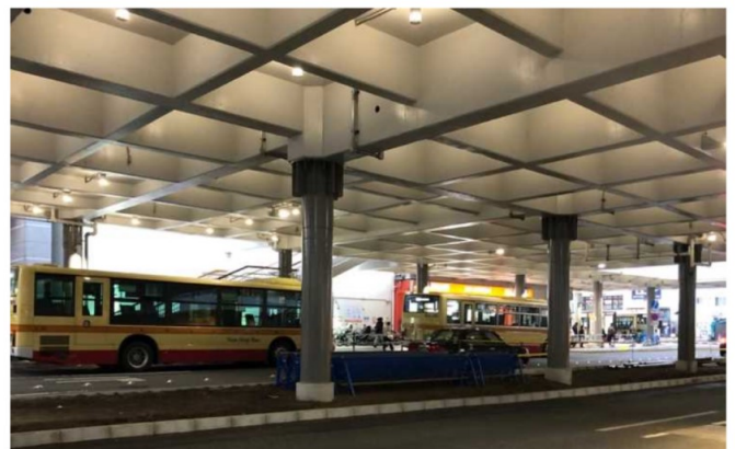
写真1 グリッド状のデッキ構造(リニューアル後)
