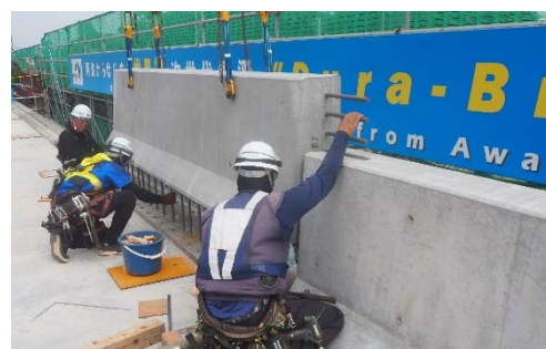
写真-1 壁高欄の架設
