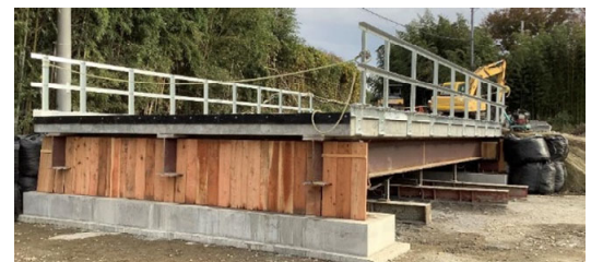
実証橋全景（スロープ埋め戻し）
