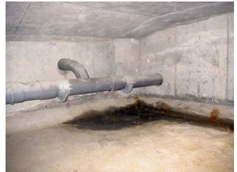
写真 1 PC 箱桁橋塩害の事例
