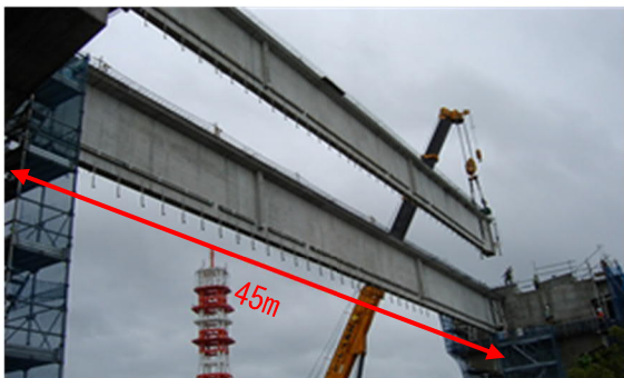
図-1 PCT 桁の架設状況
