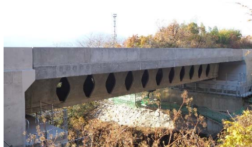
写真-2 別壱谷橋
