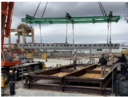
①床版パネル架設状況
