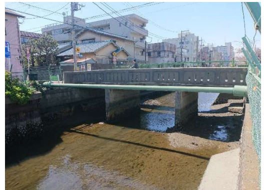
写真-1 検討対象橋梁
