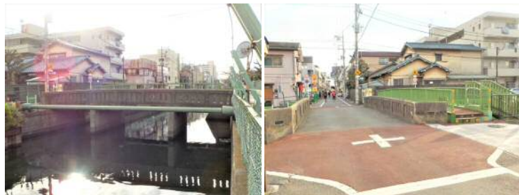
写真-1 現在の対象橋梁
