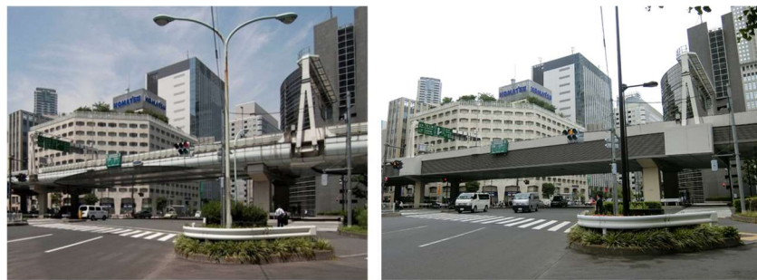
写真-1 視察橋梁(左: 美化設置時, 右: 常設足場設置時)
