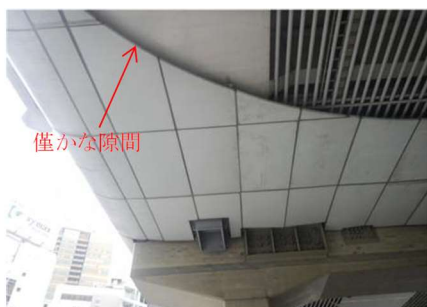
写真-2 点検時の近接困難箇所
