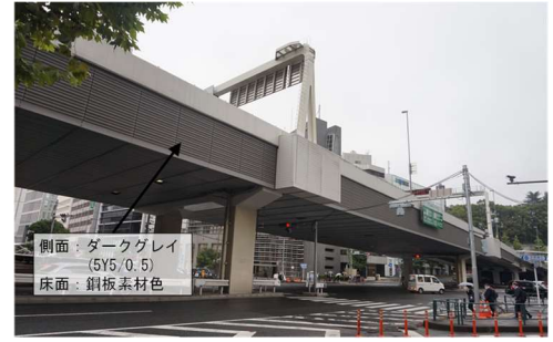
写真-4 常設足場塗装色
