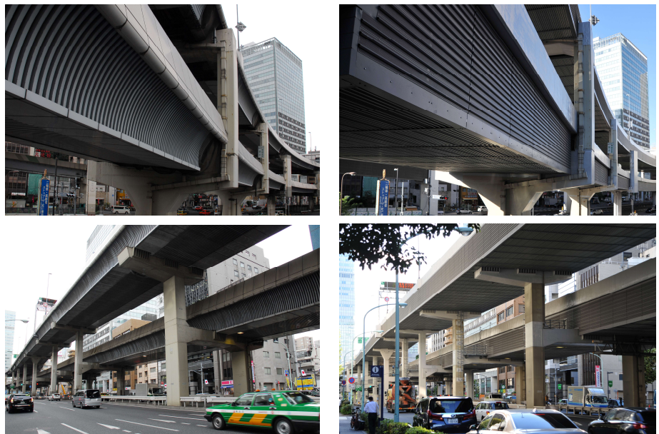
写真-5 同一視点場の比較 (左: 美装化設置時, 右: 常設足場設置時)
