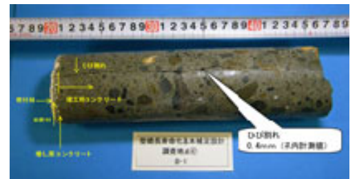
写真4. RCアーチ躯体のコア写真
