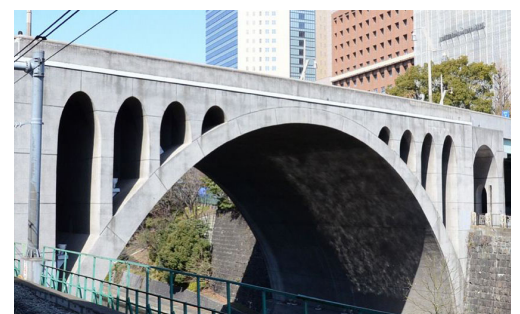
写真3. 平成の聖橋（石張り風仕上げ）
